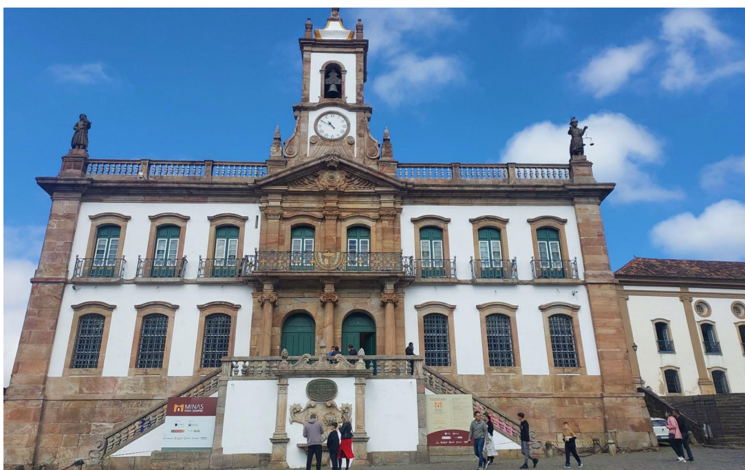
Fachada frontal do Museu da Inconfidência
